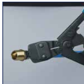
Grapa la abrazadera con el equipo adecuado para tener una conexión segura
