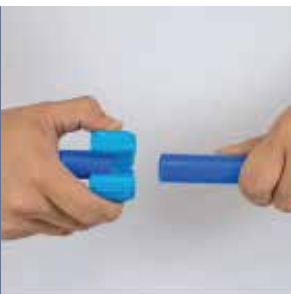
Realiza un corte recto en la Tubería PEX
